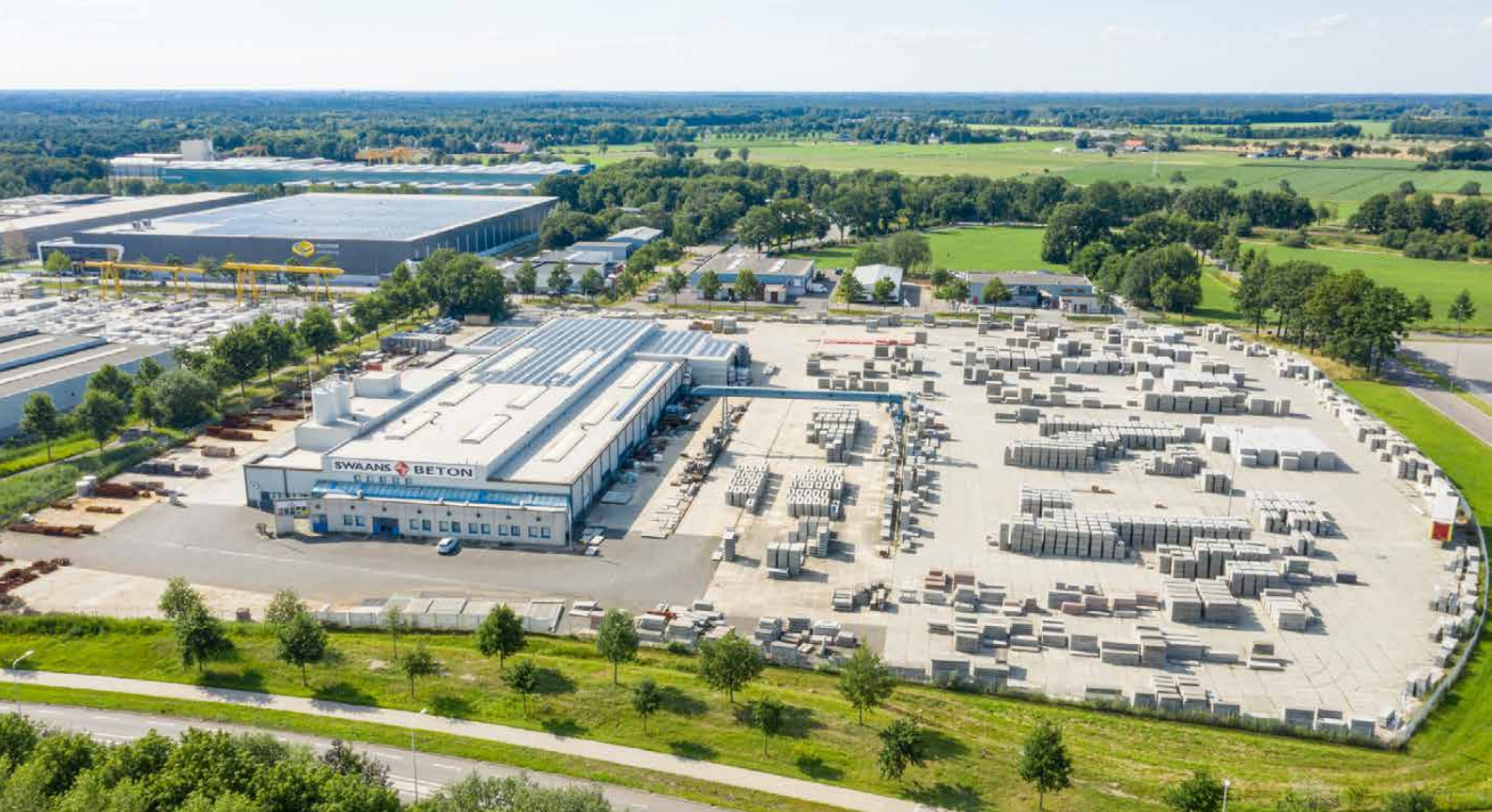
Productielocatie Swaans Beton
